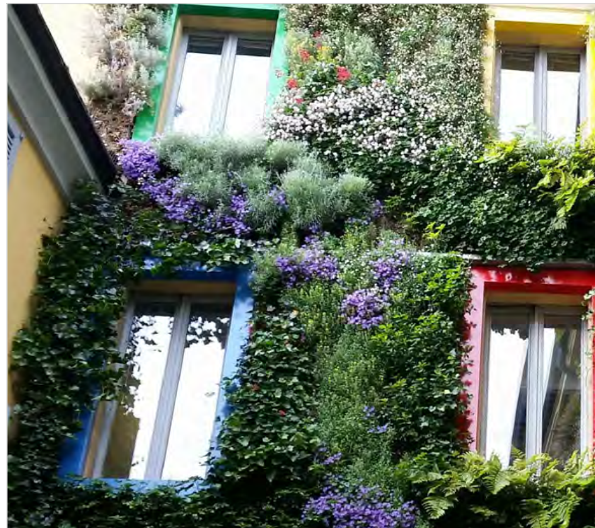
Parete verde a 60 gg dall'impianto
