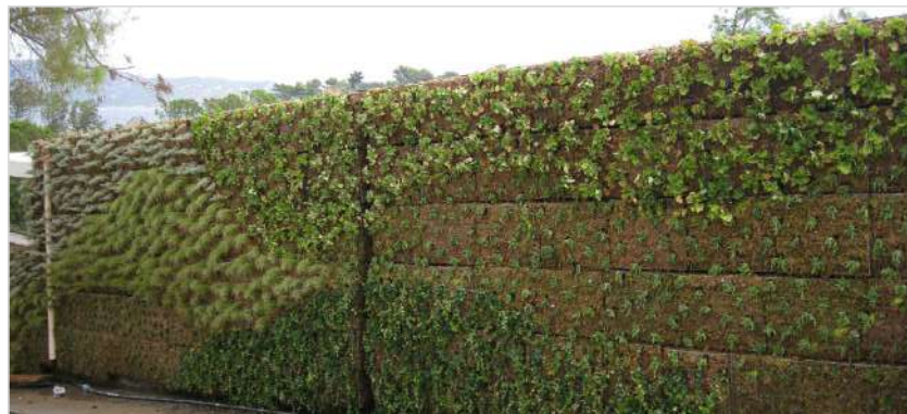
Parete rivestita con green box rinverditi
