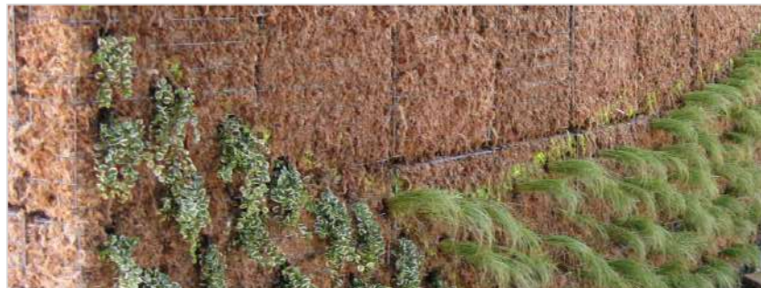
Parete in fase di piantumazione
